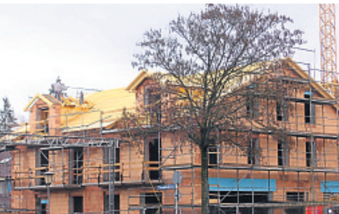
Hier entsteht ein Wohn- und Geschäftshaus in München.
